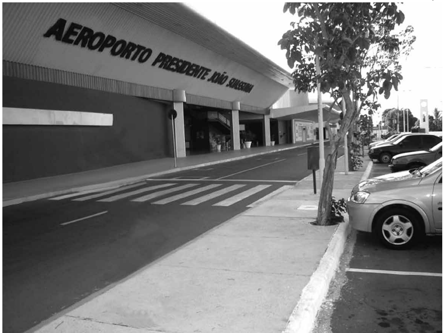
Aeroporto João Suassuna foi incluído no Programa de investimentos em Logística do Governo Federal que visa ampliar e fortalecer terminais
