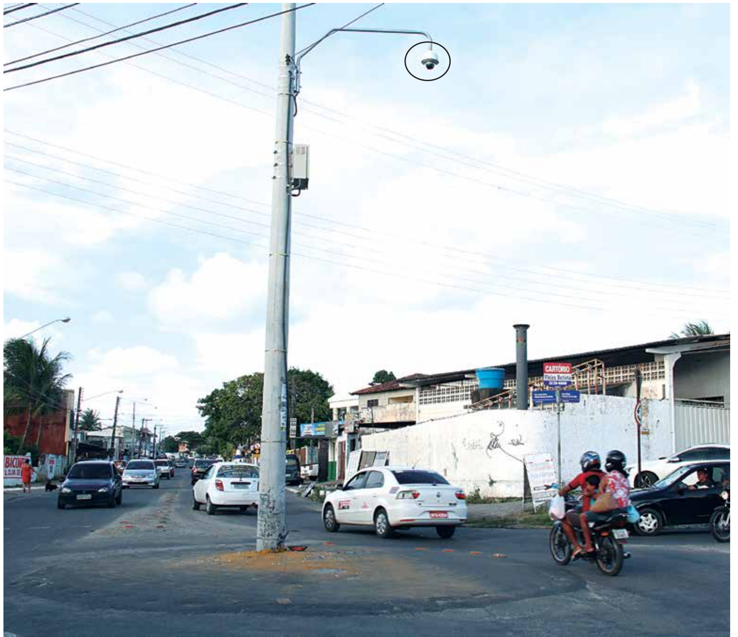
As câmeras (detalhe) instaladas na capital são de alta resolução, com movimento de 360 graus e alcance de até 500 metros
